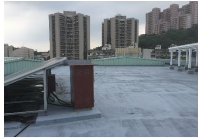
屋頂隔熱現勘
